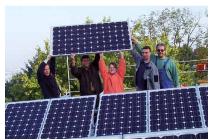
Installation einer PV-Anlage auf dem Schüldach
